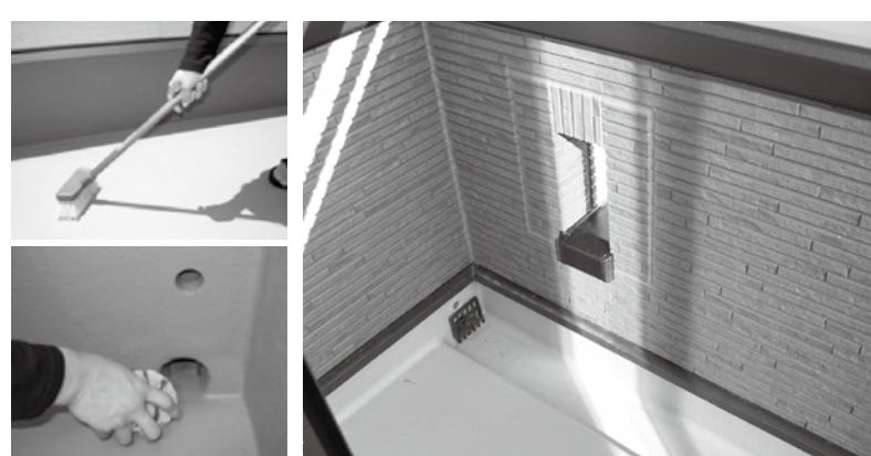
◆排水口がゴミや落葉などで塞がっていると台風や集中豪雨の時などに思わぬ事故(バルコニーがブーム状になる・下階に水漏れを起こすなど)が起ります。清掃した時に一緒に排水口のまわり及びオーバーフロー管の点検と掃除をおすすめします。受け皿を外して管の中までチェックするよりよいです。
